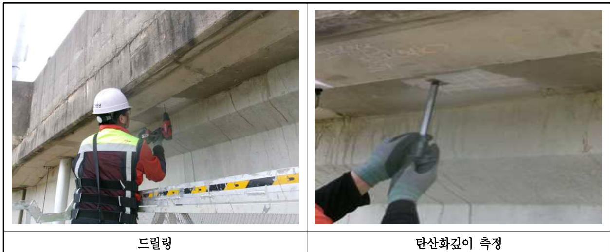
【사진 28.4.3】 탄산화 깊이 측정 현장사진
