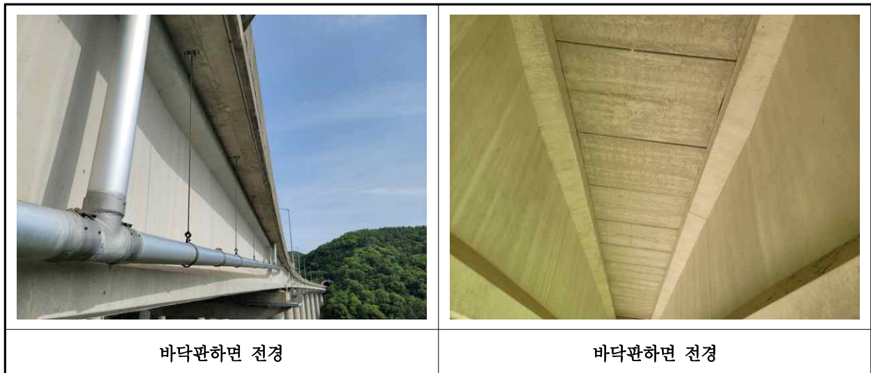
【사진 28.3.2】 바닥판하면 전경
