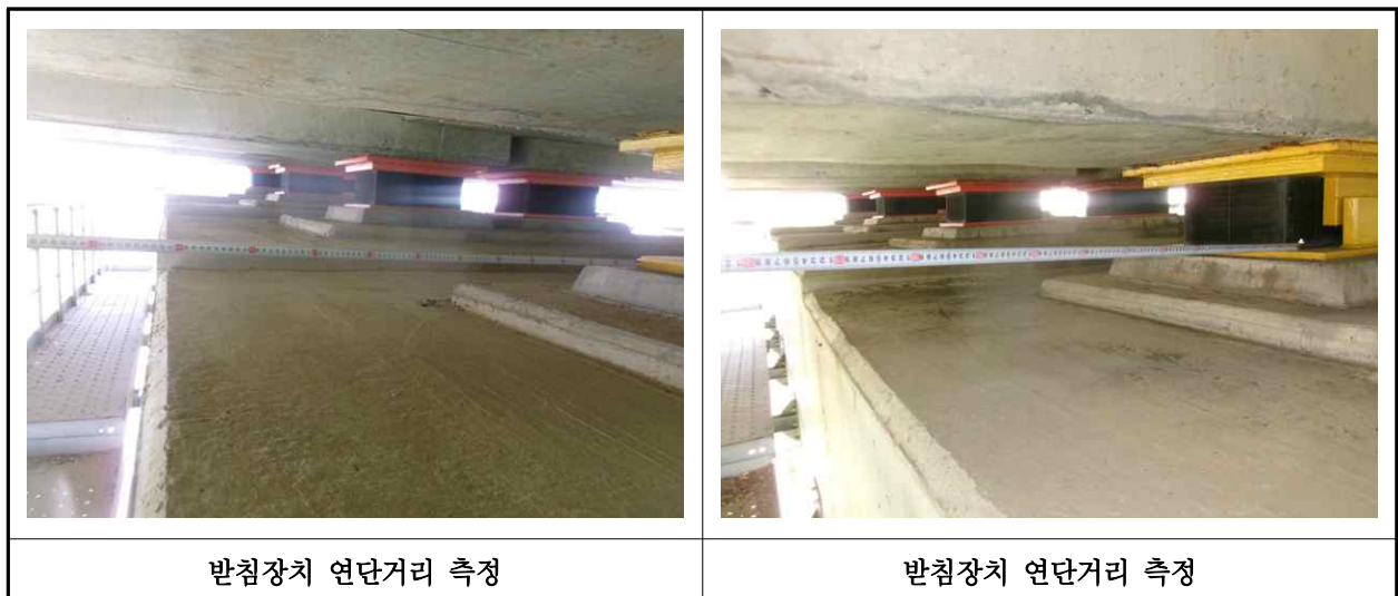
【사진 28.3.15】 교량받침장치 연단거리측정
