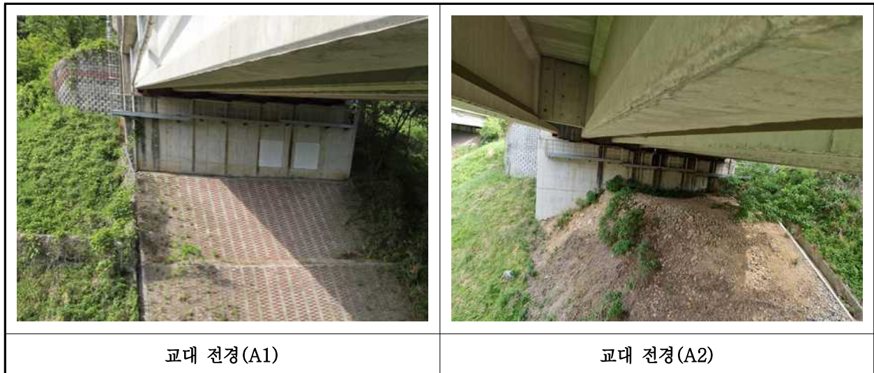
【사진 28.3.8】 교대 전경
