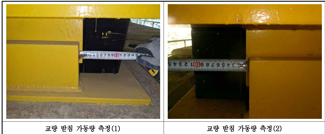
【사진 28.3.16】 교량받침 이동량 측정
