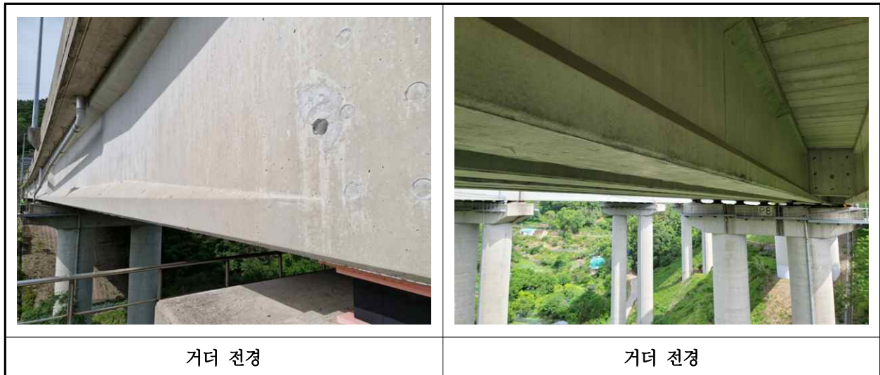
【사진 28.3.4】 거더 전경
