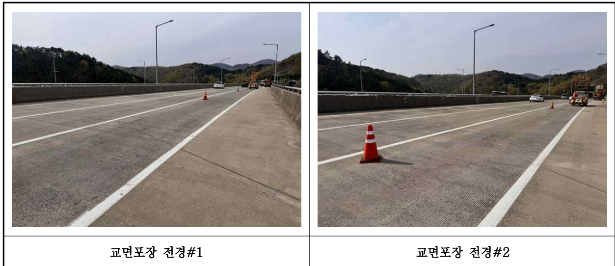
【사진 28.3.20】 교면포장 전경
