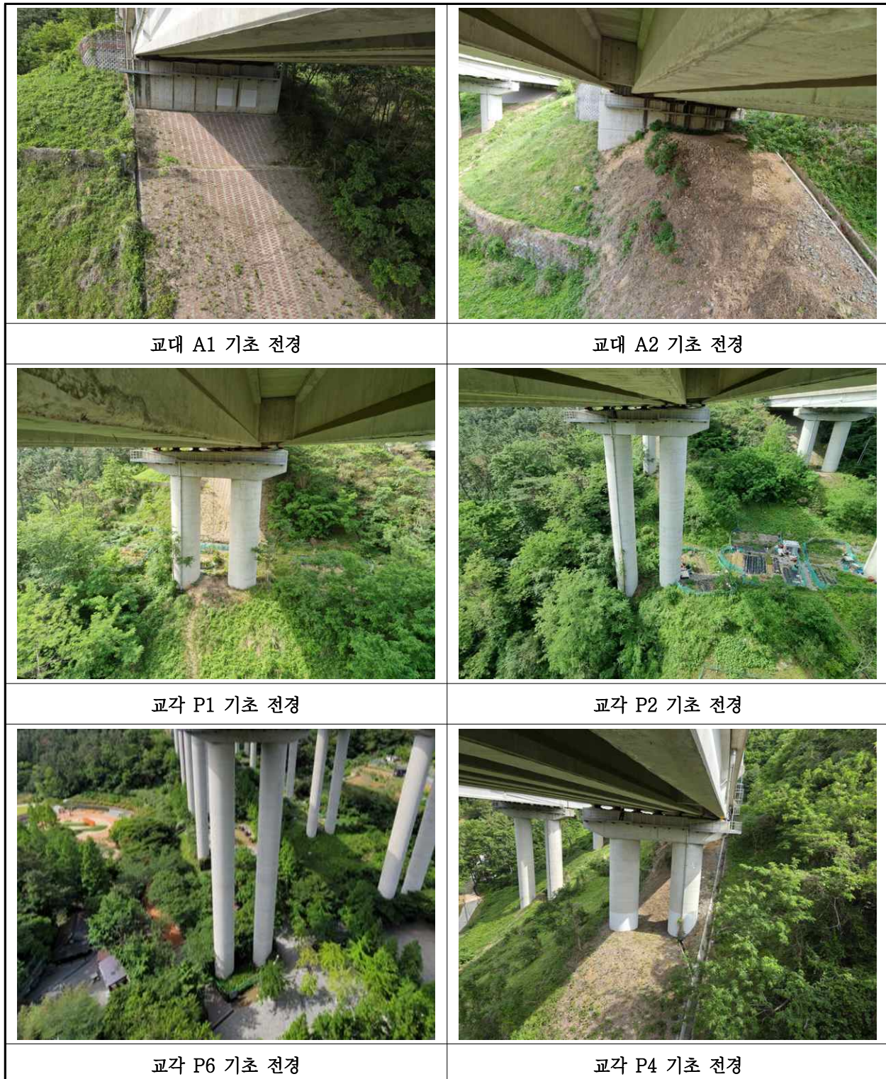
【사진 28.3.12】 기초 전경
