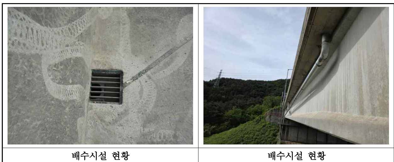
【사진 28.3.22】 배수시설 전경
