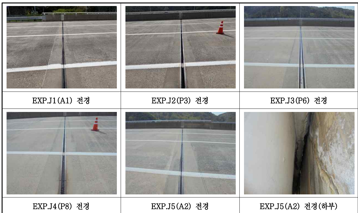
【사진 28.3.17】 신축이음장치 전경
