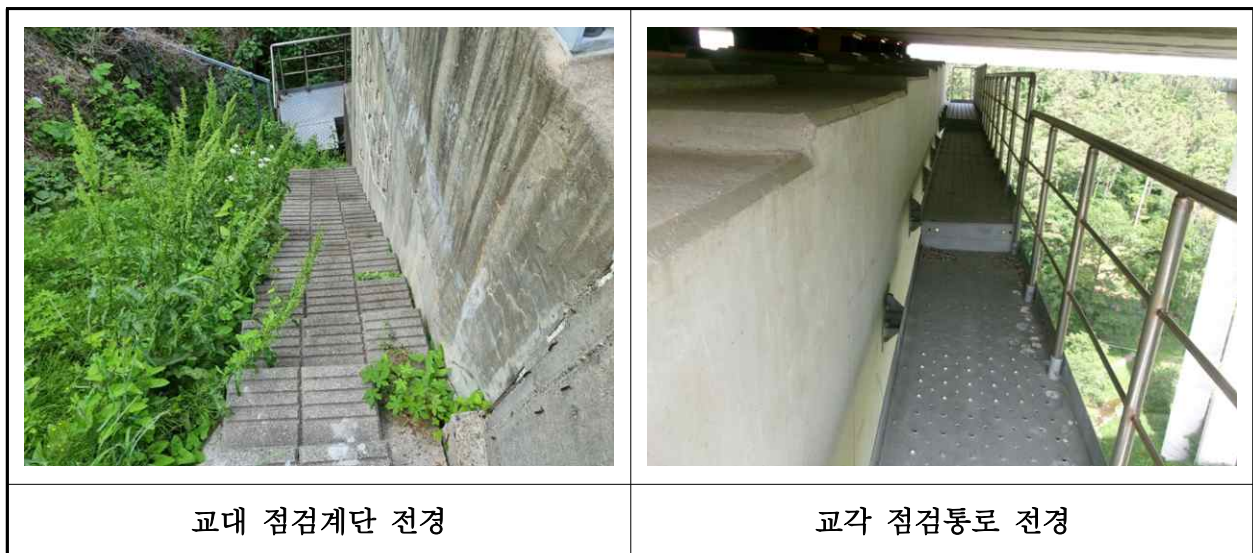
【사진 28.3.26】 교량 점검시설 전경
