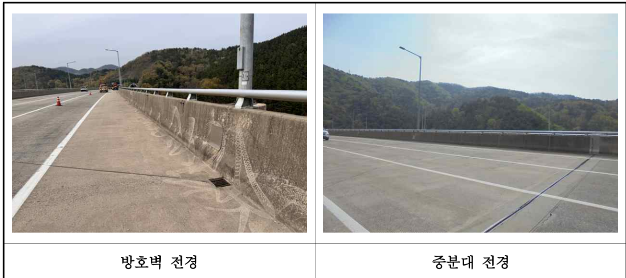
【사진 28.3.24】 방호벽 및 중분대 전경
